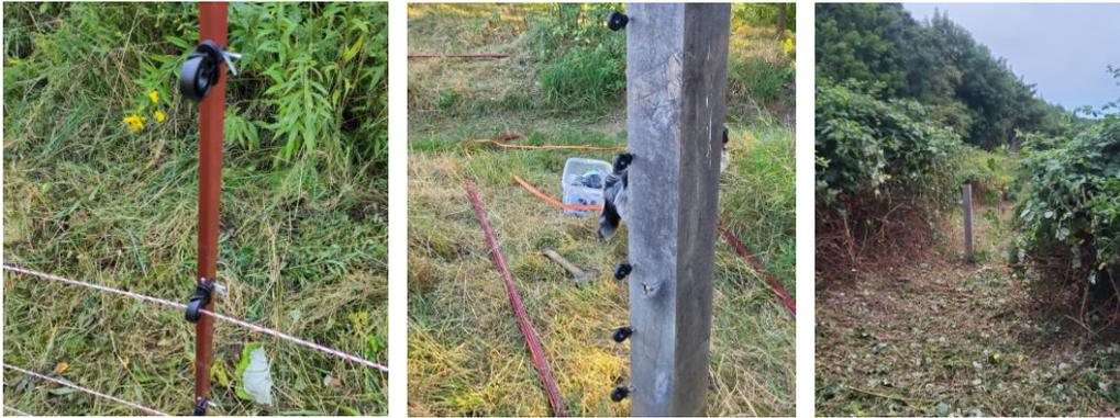
Abbildung 19 Links: Erweiterung der Zauntrasse durch Winkeleisenpfähle; Mitte: Anbringen von Isolatoren an den Pfählen; Rechts: Freischneiden der Zauntrasse
