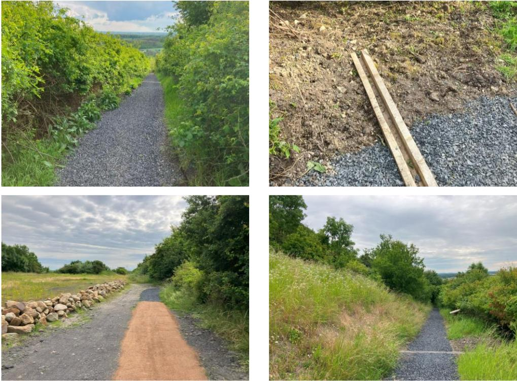
Abbildung 15 Oben links: Neue Deckschicht Zickzackweg; Rechts: Abflussrinne aus Eichenholz. Unten links: neu gestalteter Übergang vom Hauptweg zum Zickzackweg; Rechts: Instandgesetzter Zickzackweg mit Abflussrinne
