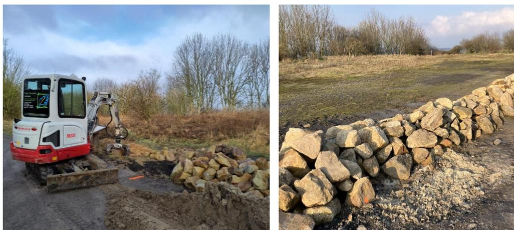
Abbildung 6 Links: Auskoffern der Gruben mit Mini-Bagger; Rechts: Steinriegel nach der Maßnahme inkl. Sandgrube auf der Südseite
