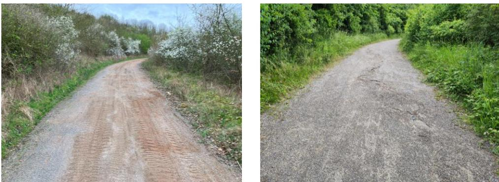
Abbildung 12 Links: Ausgebesserter Hauptweg mit Dolomit-Sand; Rechts: Erosionsrinne in der Deckschicht.
