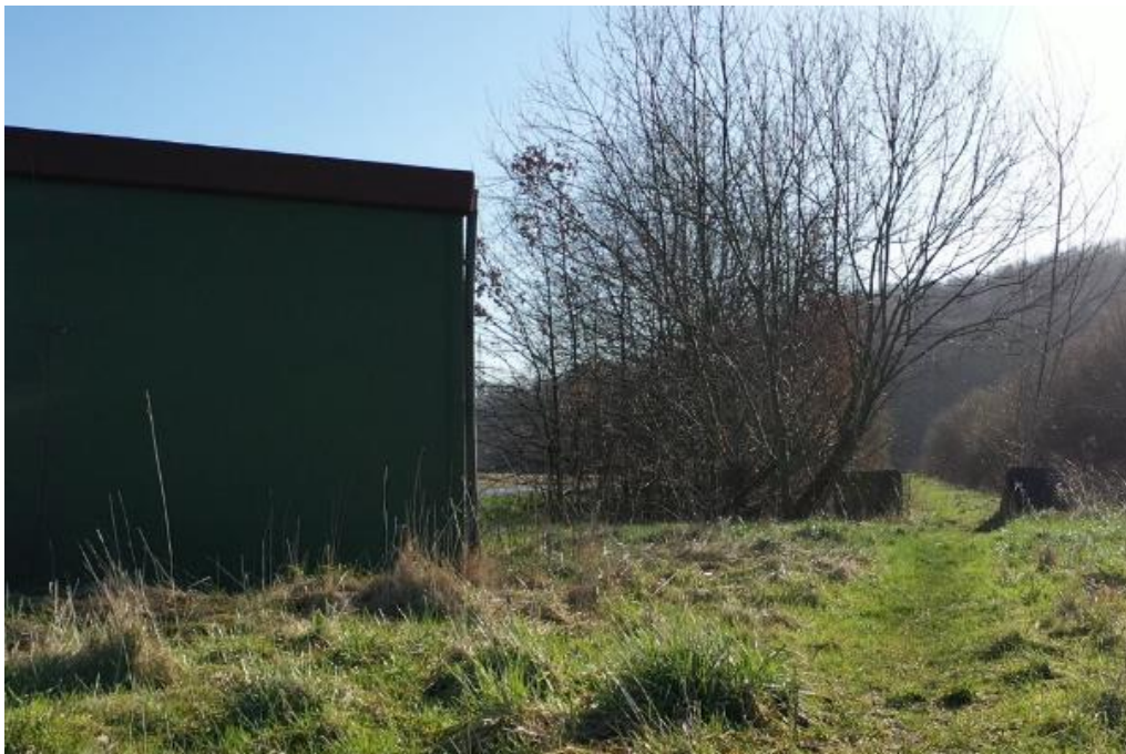
Abbildung 81 Polderanlage östlich von Haver (03/2022)
