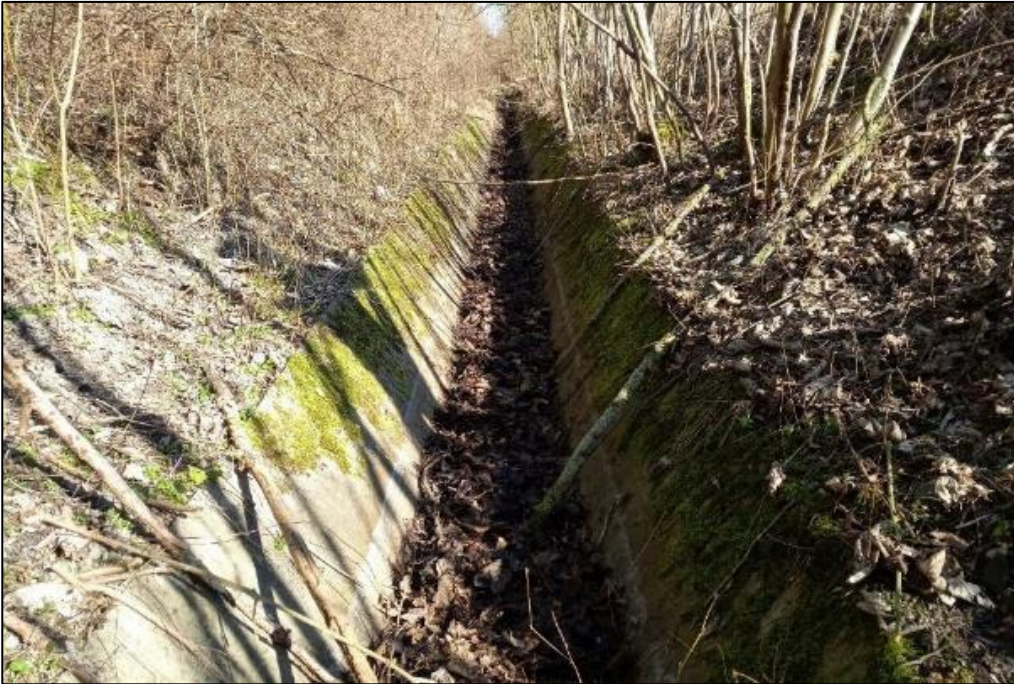
Abbildung 10 Beispiel für einen in der BT-Kulisse berücksichtigten, verschalten Grabenabschnitt im Südwesten (03/2022)
