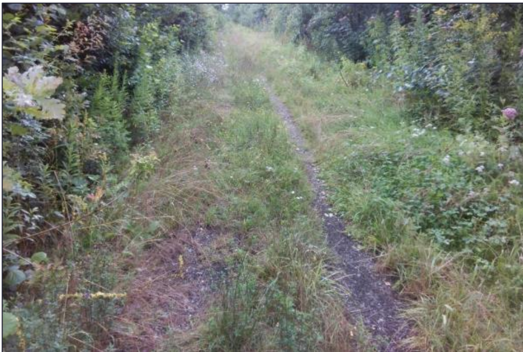
Abbildung 76 Bestandsaufnahme eines stark bewachsenen Wegabschnitts im Norden auf der ersten Berme (07/2021)
