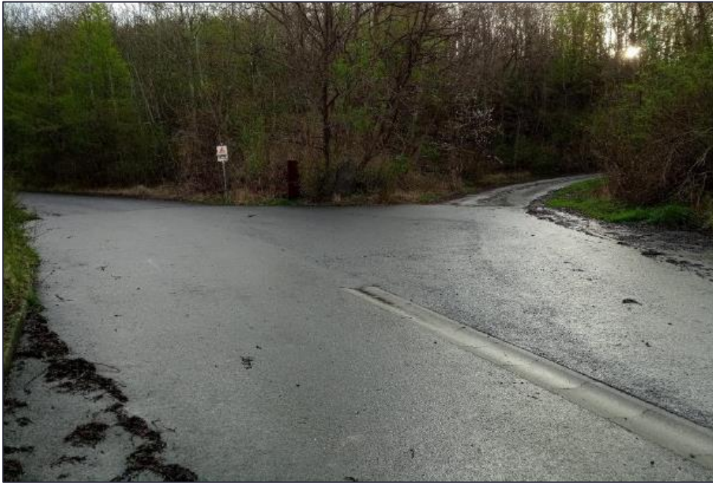
Abbildung 77 Bestandsaufnahme des asphaltierten Wegenetzes an der Gabelung des nördlichen und südlichen Weges zum Plateau im Westen der Halde (02/2022)
