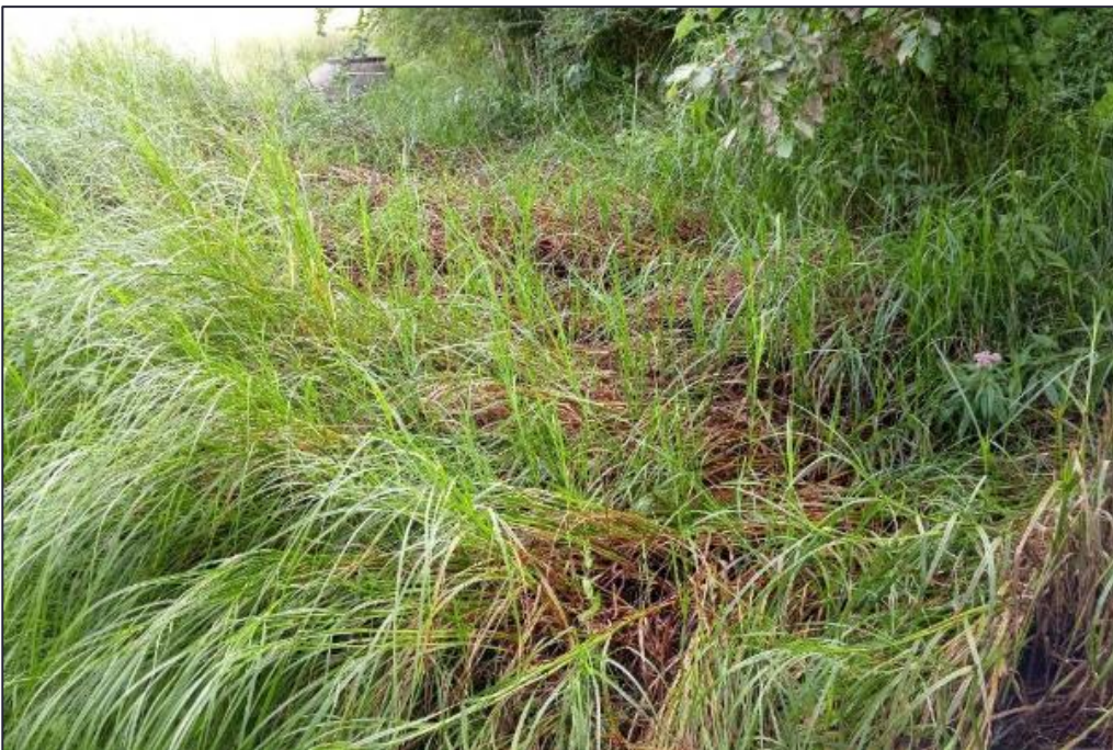
Abbildung 7 Breiter, flacher Grabenabschnitt im Norden, östlich vom Haver Werksgelände (07/2021)
