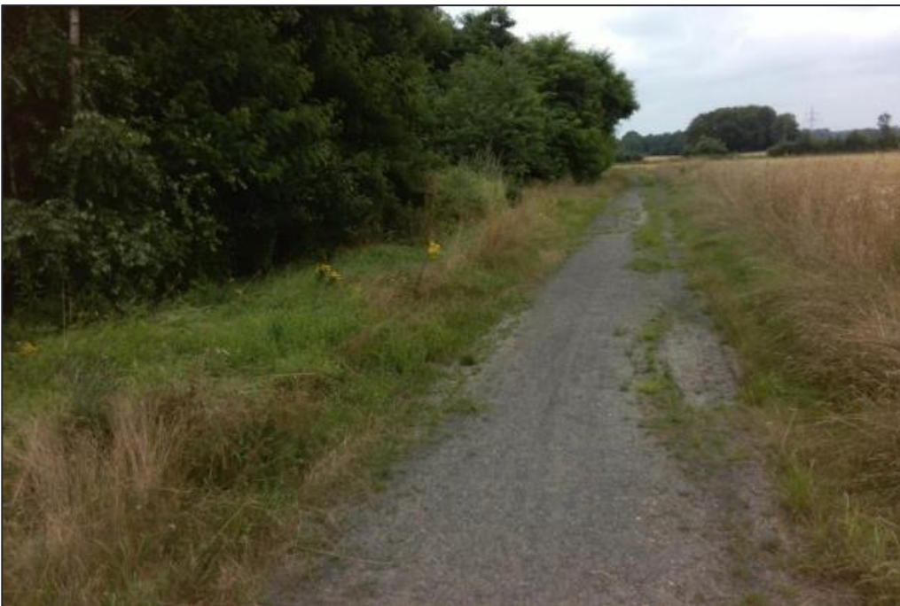
Abbildung 74 Bestandsaufnahme eines stark von Tritt und Befahrung geprägten Wegabschnitts des Rundweges am Fuß der Halde (07/2021)
