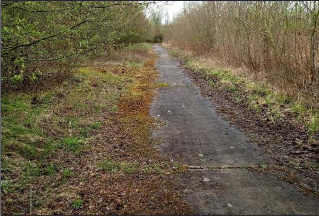
Abbildung 78 Bestandsaufnahme des mit Betonplatten ausgelegten Fahrweges östlich der ehemaligen Flotationsbecken (02/2022)
